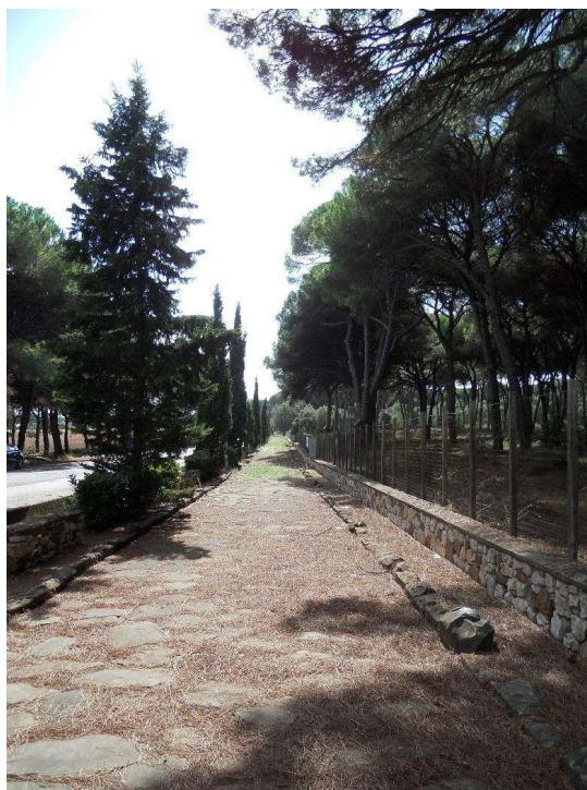
La Selciatella presso la pineta della Campana: il basolato di selce della strada che da Lanuvio scendeva ad Antium, ancora percorribile a piedi. (Foto Latium Vetus et Adiectum, ricognizione 2016)
