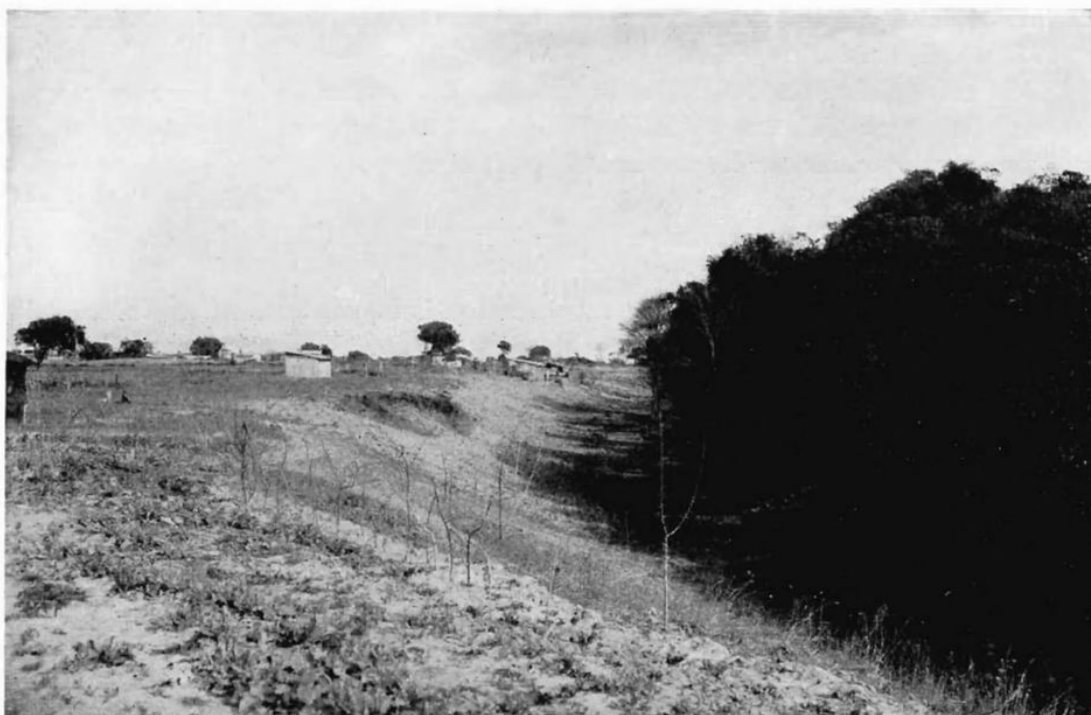
Il vallo nel lato settentrionale come lo fotografò Lugli: «vallo e fossa appaiono nella loro quasi integrità per oltre un chilometro e mezzo». (Lugli 1940, fig. 1)
