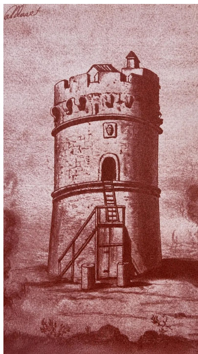
La torre delle Caldane in un disegno architettonico storico: tonda e merlata, con la porta rialzata cui si saliva per una scaletta esterna. (da Miselli 1691)
